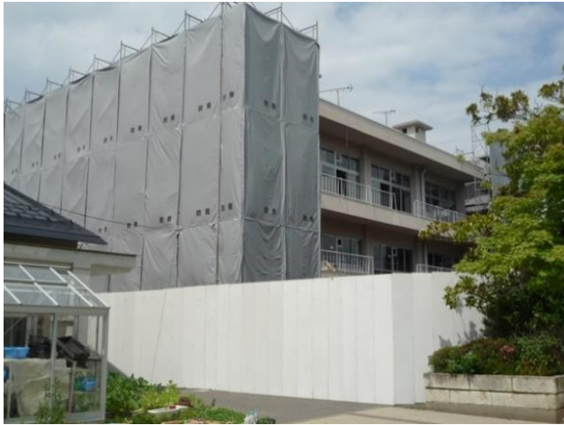
解体前に仮囲いされた旧長野市教育会館
